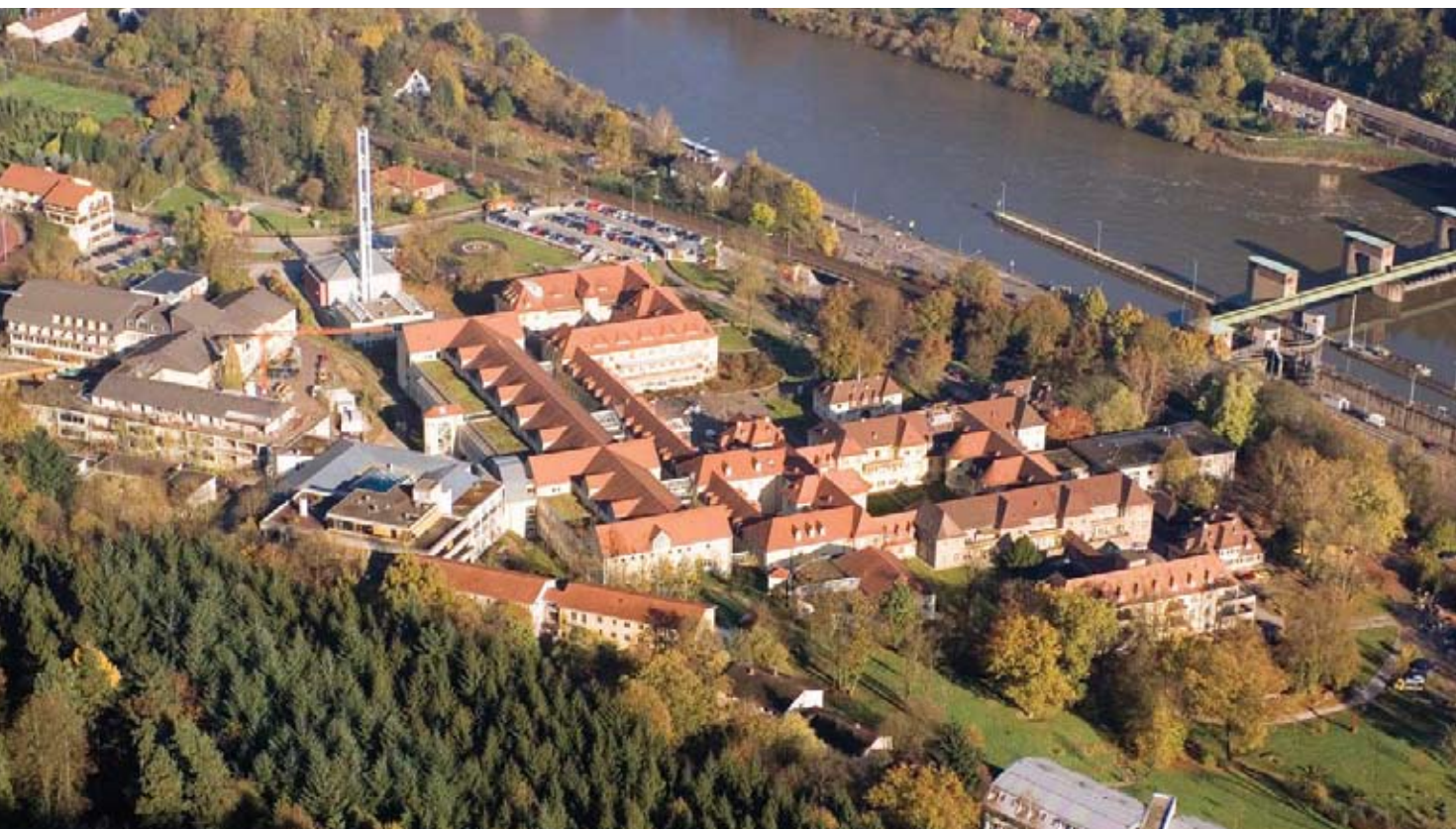
Die Orthopädische Universitätsklinik im Heidelberger Stadtteil Schlierbach.
